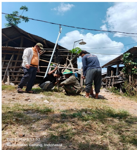
Gambar 3. Tim pengabdian sedang memasang tiang untuk Photovoltaic
