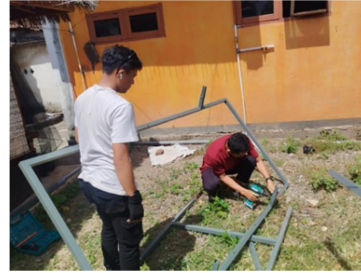
Gambar 3. Perakitan rangka pendukung panel surya
