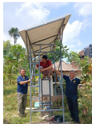
Gambar 6. Penyambungan kabel ke kontrol MPPT
