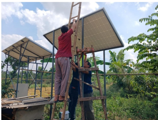
Gambar 5. Pemasangan panel surya
