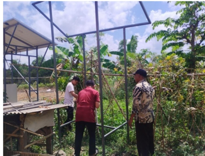
Gambar 4. Pemasangan rangka pendukung panel surya
