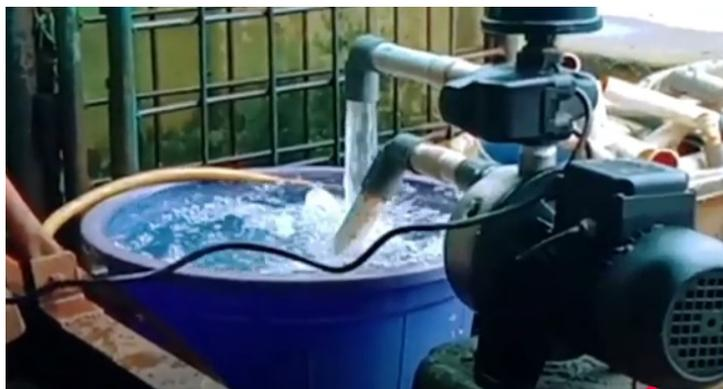
Gambar 1. Instalasi Pemasangan Pompa Rumah Tangga Tanpa Sistem Kontrol
