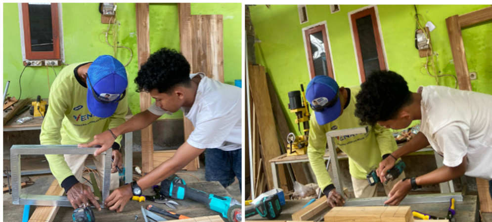
Gambar 3. Proses penyambungan kerangka baja ringan
