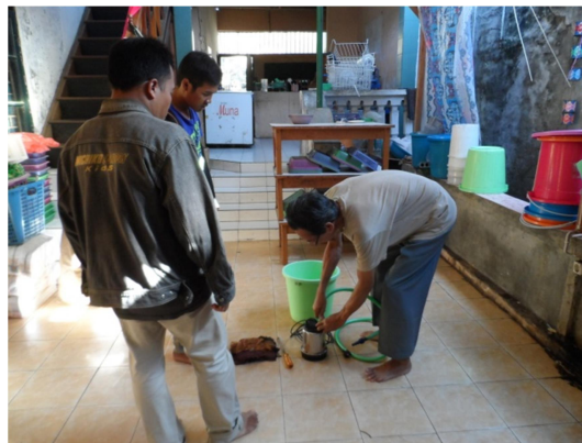
Gambar 3: Pemasangan selang pada pompa submersible
