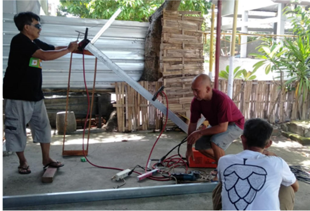
Gambar 7. Pembersihan sisa pengelasan
