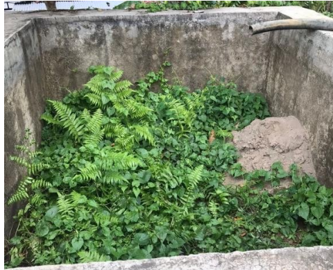
Gambar 3. Kondisi Bak Saat Tidak Terpakai
